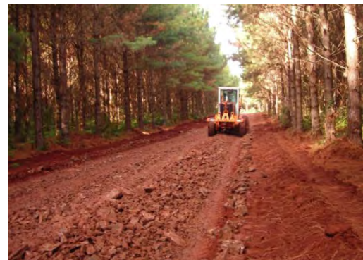
Imagen n° 5: Distribución de tosca con motoniveladora Picture n° 5: Distribution of altered basalt with grader
