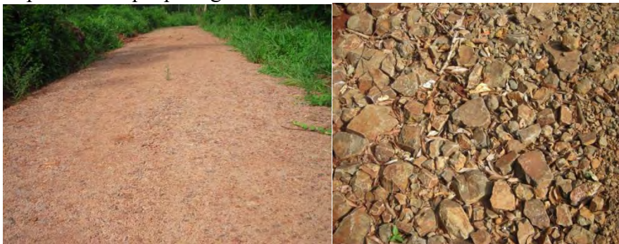
Imagen n° 7: Consolidación de tosca reposado
