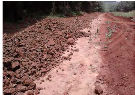
Imagen n° 4: Caballetes o montículos de tosca distribuidos sobre la base Picture n° 4: Stock-altered basalt distributed on the road
